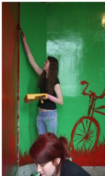
16. attēls. Velosipēdu novietnes remonts
